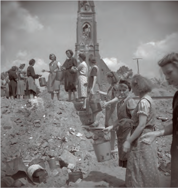
Немки работают на расчистке завалов
