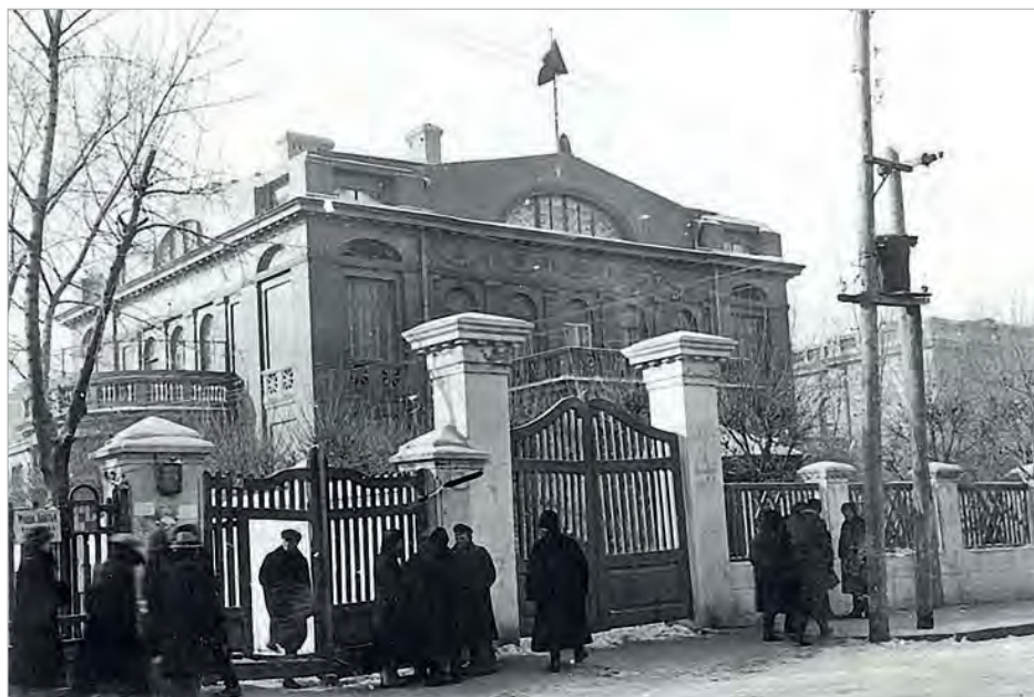
Здание Генконсульства в Харбине. 1929 г.
