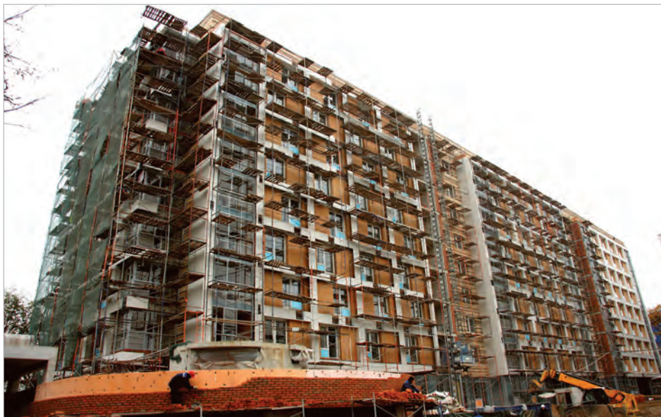
Завершение фасадных работ в ноябре 2016 года
